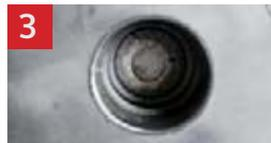
**3** Inspectez l'état des trous de fixation. Pensez à utiliser des bouchons SACLIP® pour éviter tout colmatage de la cavité par l'enrobé
